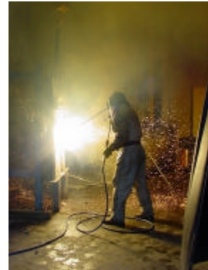
Selbst den aggressivsten elektromechanischen und thermischen Angriffswerkzeugen haben die Wertschutzräume standgehalten
