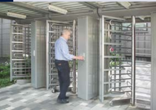
Als Mitarbeiterdurchgang: Mehrfachanlage am Zaun in Werksgelände
