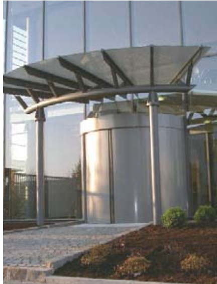
Zusätzliche Sicherheit - Vierflügelige Karussell- tür mit Nachabschluss
