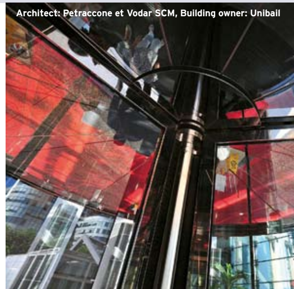
Fluchtweggeprüftes Türflügelkreuz - Die Flügel lassen sich manuell abklappen, so dass fliehende Personen ohne Hindernis ins Freie gelangen können.
